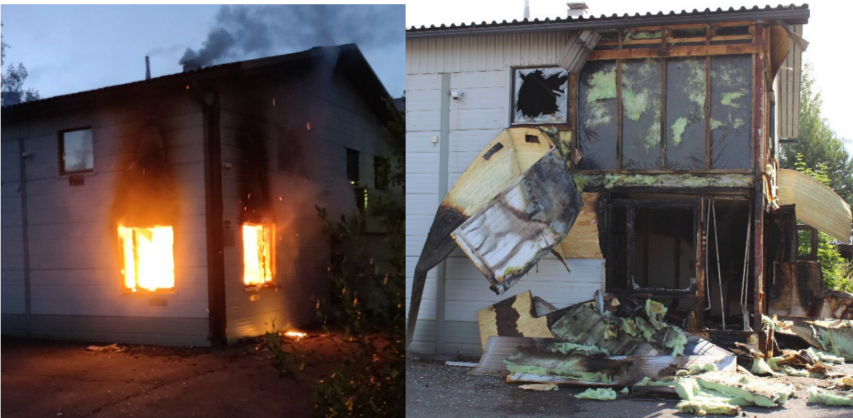
Kuva 12. Lahti Erstantie, teollisuusrakennus. Paloa epäillään tahallaan sytytetyksi.
