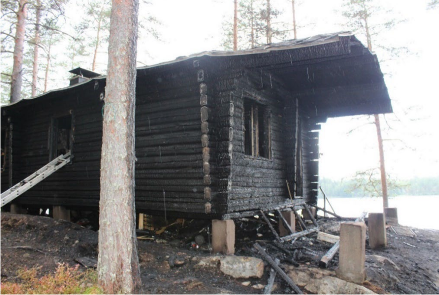
Kuva 13. Heinola Iso-Palpasenkatu, vapaa-ajan asunto. Syttymiskohta rakennuksen ulkopuolella kuistilla. Syttymissyttä ei voida varmuudella sanoa.
